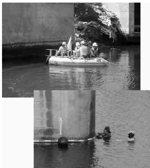
写真 - 4 ボートや潜水夫による洗掘調査
