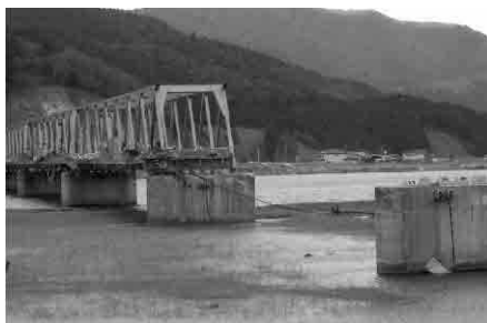
写真-1 左岸側の上部工落橋状況
