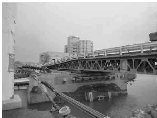
写真 - 1 流失した川原川橋の応急橋による復旧
