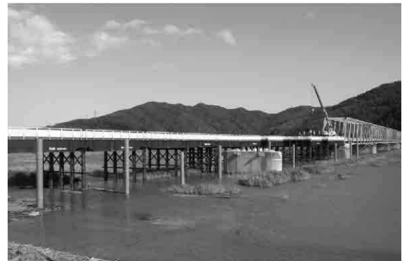
写真 - 8 完成した仮橋
