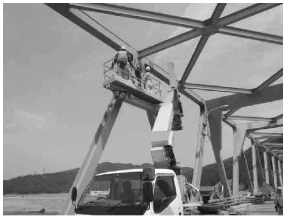
写真 - 6 トラス桁損傷状況調査
