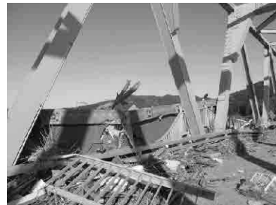
写真-3 歩道部コンクリート床版のめくれ
