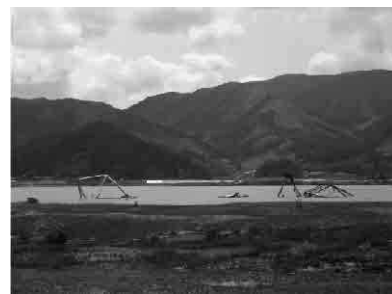
写真-2 上流に流出したトラス桁
