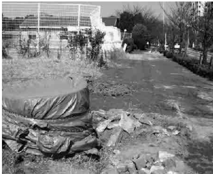
写真 - 1 マンホールの被災状況
