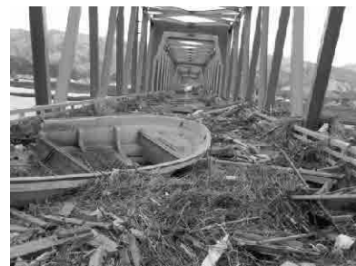
写真-4 橋面に打ち上げられたガレキ
