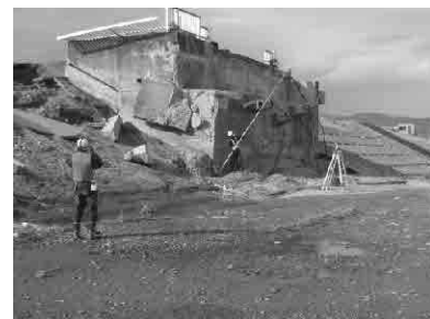
写真-5 落橋部の下部工
