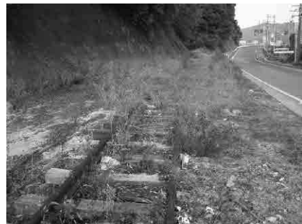
写真-1 山田線津軽石駅近くの線路埋没状況 (筆者写す2011/11/3)
