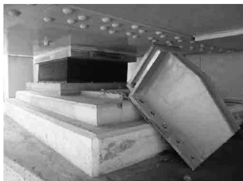
写真 - 2 ジョイントプロテクターが損傷した橋梁
