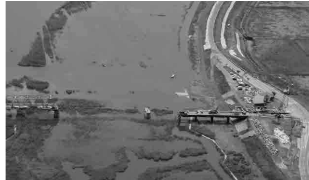
写真 - 7 施工中の仮橋
